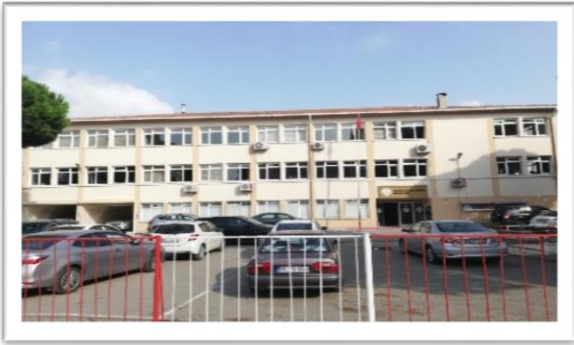
Kızılırmak İlkokulunun bahçesindeki ek bina tadilat yapılarak 18/01/2016 – 05/06/2023 tarihleri arasında Bafra İlçe Milli Eğitim Müdürlüğü hizmet binası olarak kullanılmıştır.
