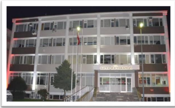
Cumhuriyet Mahallesi Hükümet Caddesinde bulunan Kaymakamlık Binasının 1. Katında 1980 - 2011 yılları arasında hizmet vermiştir.
